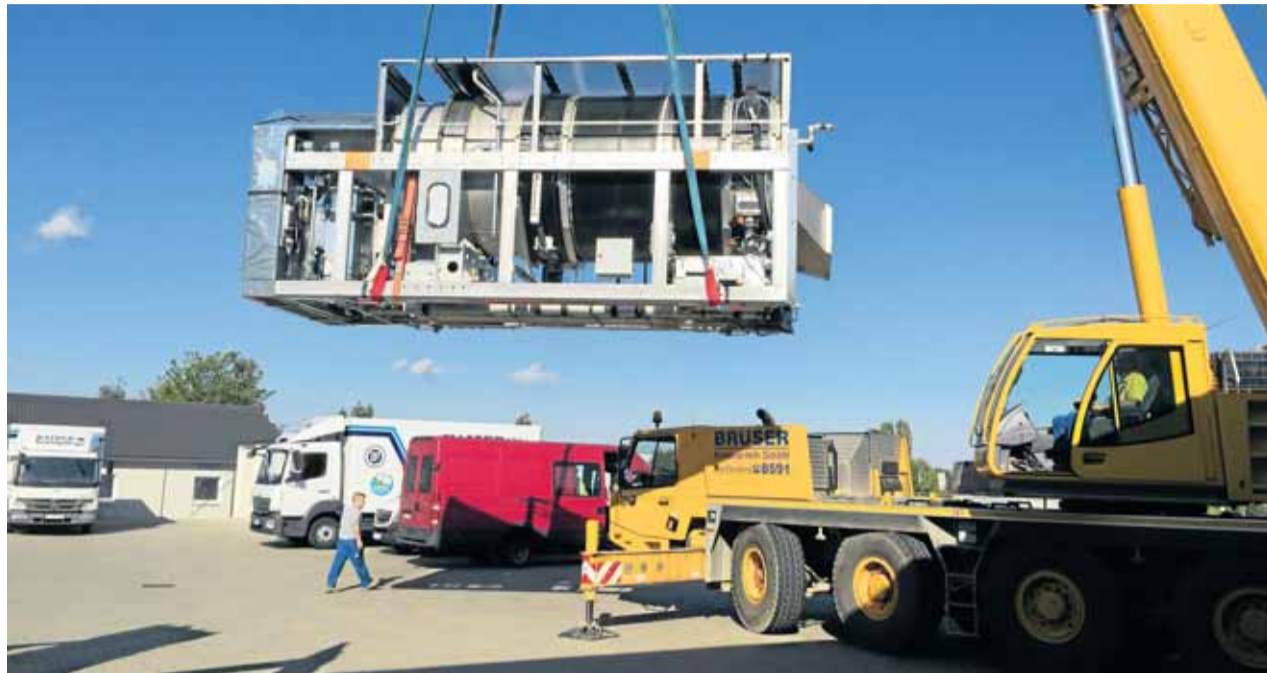
Die einzelnen Blöcke der neuen Waschstraße sind am vergangenen Samstag mithilfe eines Krans angeliefert worden. Foto: Privat
