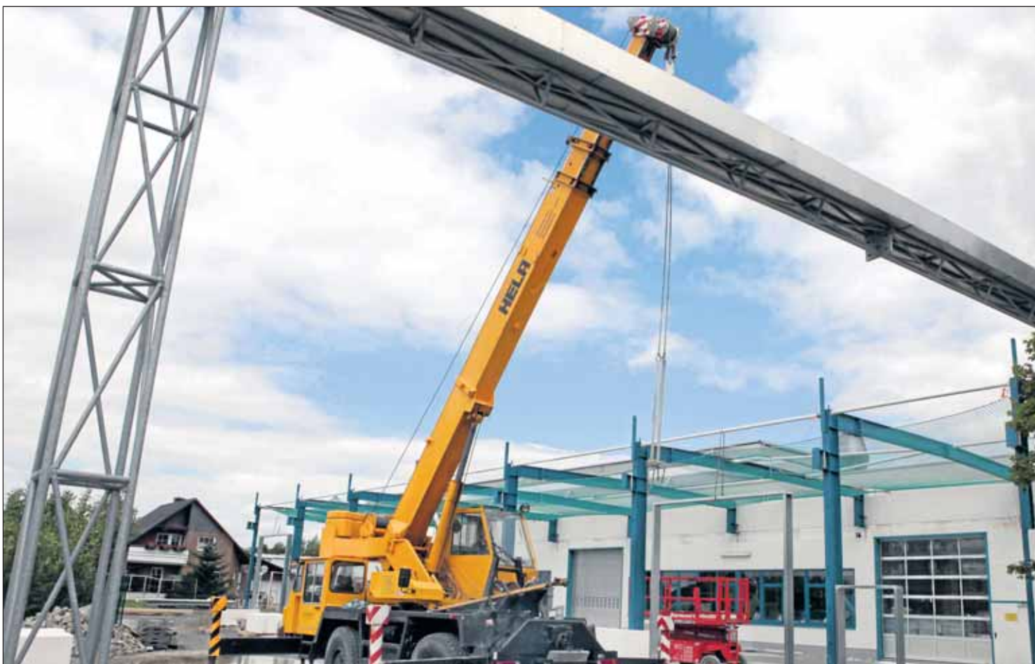
Mithilfe eines Autokranes werden die Elemente für die neue Halle an ihren Platz bugsirt. Fotos: Schenk
