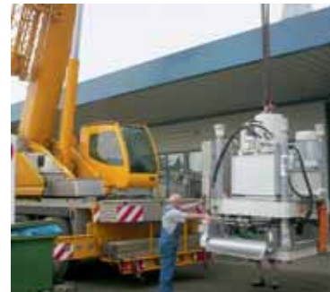
Anlieferung der neuen Presse – hier ist Präzision gefragt
